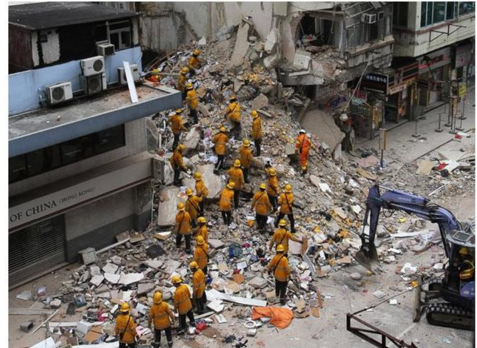
kolaps budovy v Hong-Kongu (29. leden 2010)
